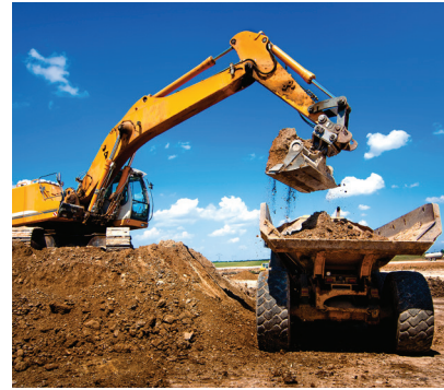
Abbildung 2: Auch unter normalen Umgebungsbedingungen kann es bei Off-Road-Geräten schnell zu Korrosion kommen
